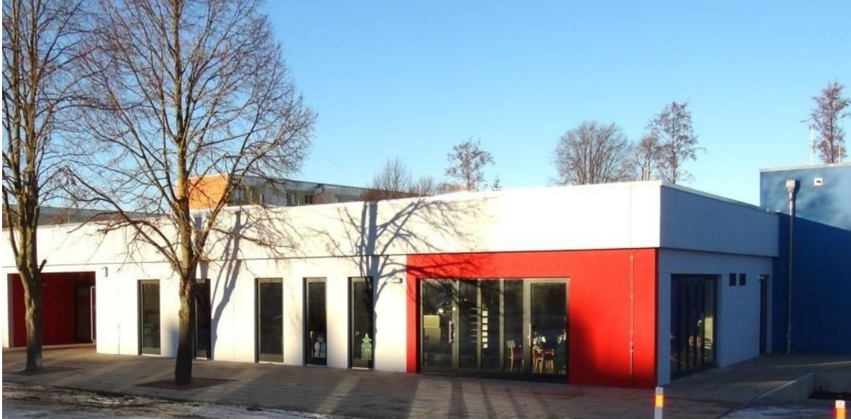
Blick auf das Begegnungszentrum Ribnitz-Damgarten in der Georg - Adolf - Demmler-Straße 6 im Stadtteil Ribnitz kurz nach der feierlichen Eröffnung im November 2016. Foto: Eckart Kreitlow
