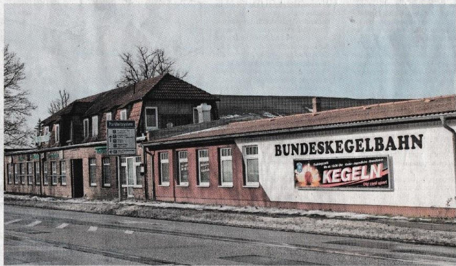
Was soll mit der Ribnitzer Kegelbahn und dem ehemaligen Sportpalast geschehen?
